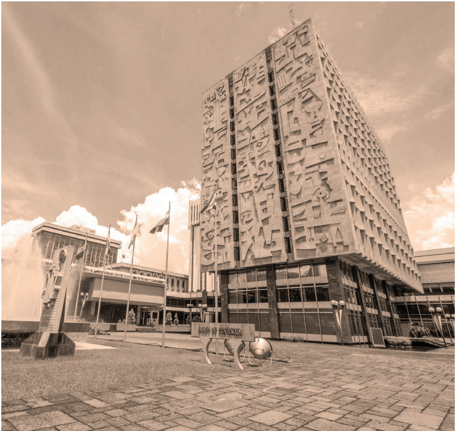
Edificio actual del Banco de Guatemala. Archivo fotográfico del Banco de Guatemala
